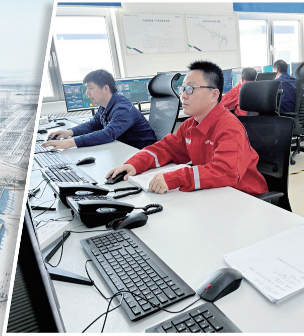
▲工作人员对风机运行等信息进行实时监测。
