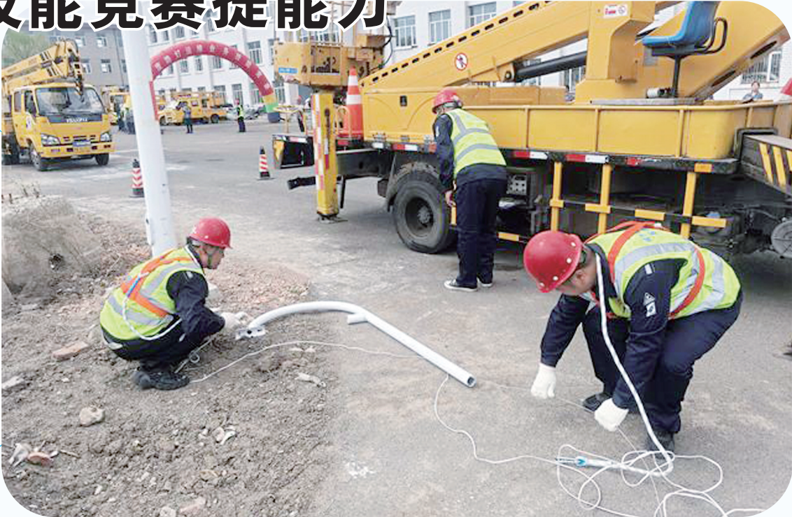
路灯运维人员模拟设施维修。
